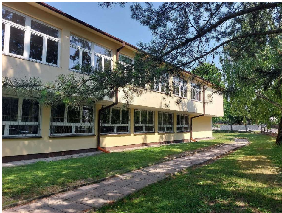
Fot. 1. Część wschodnia budynku – widok na sale 23-26.
