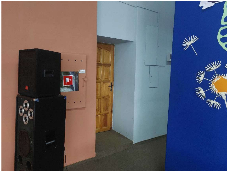
Fot. 49. Sala konferencyjna – widok na wejście do pomieszczeń nad węzłem cieplnym.
