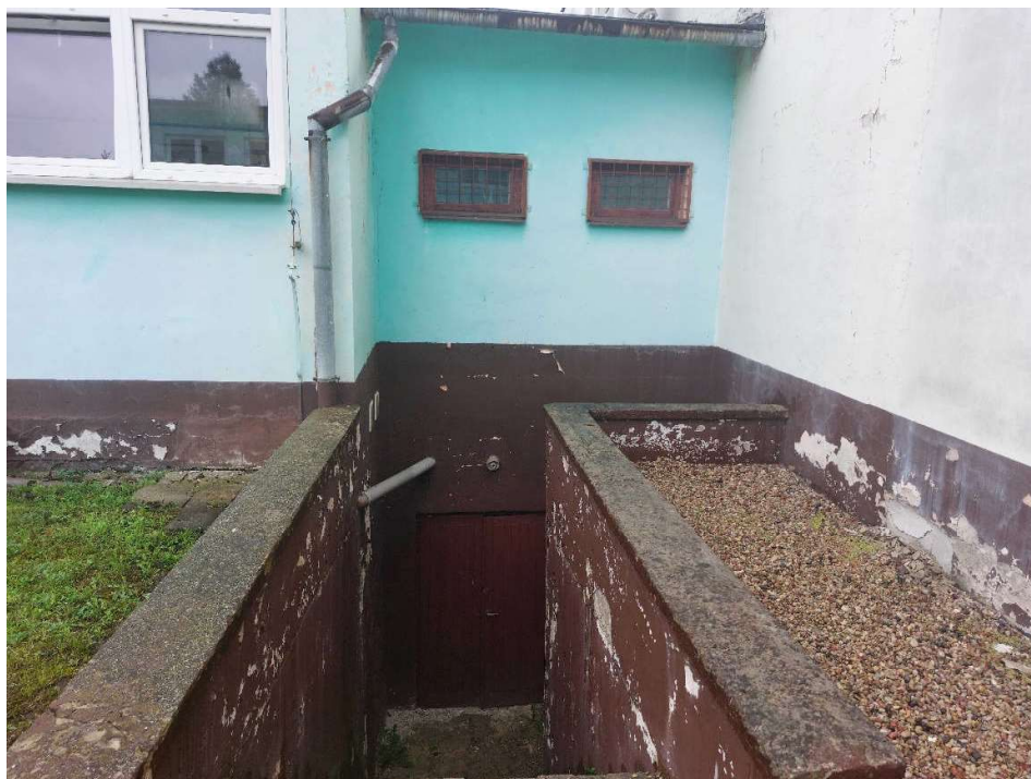
Fot. 55. Widok na wejście do wentylatorowni-wężła c.o.
