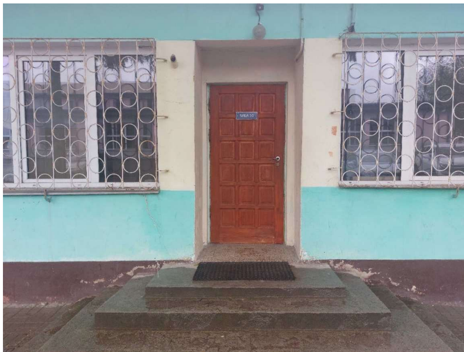
Fot. 15. Część zachodnia budynku – widok na wejście do sali nr 10.
