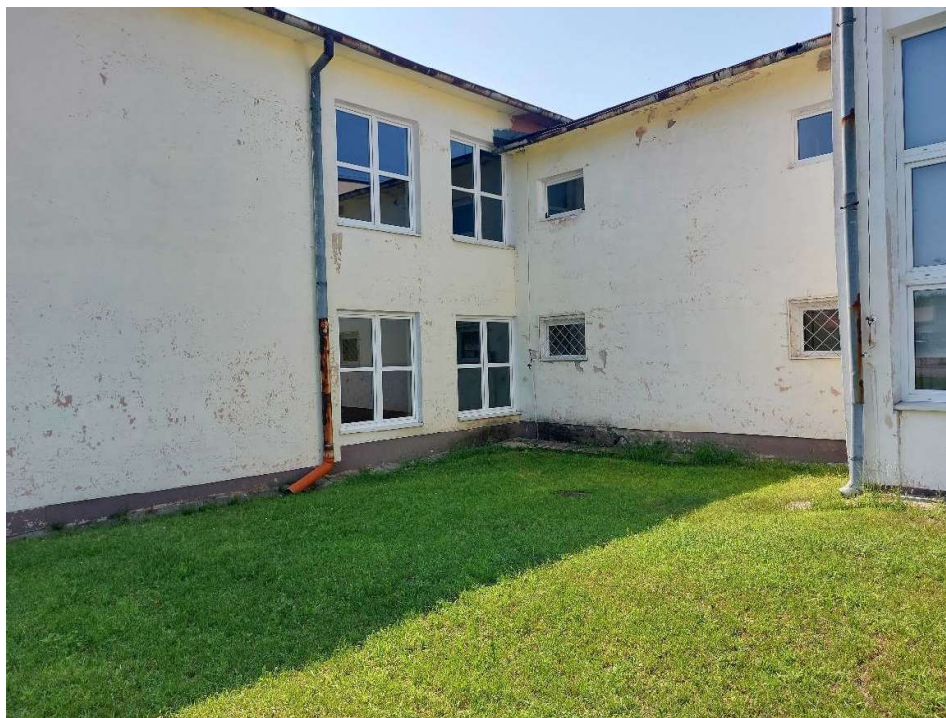
Fot. 22. Część wschodnia budynku – widok na okna korytarza i łazienki.
