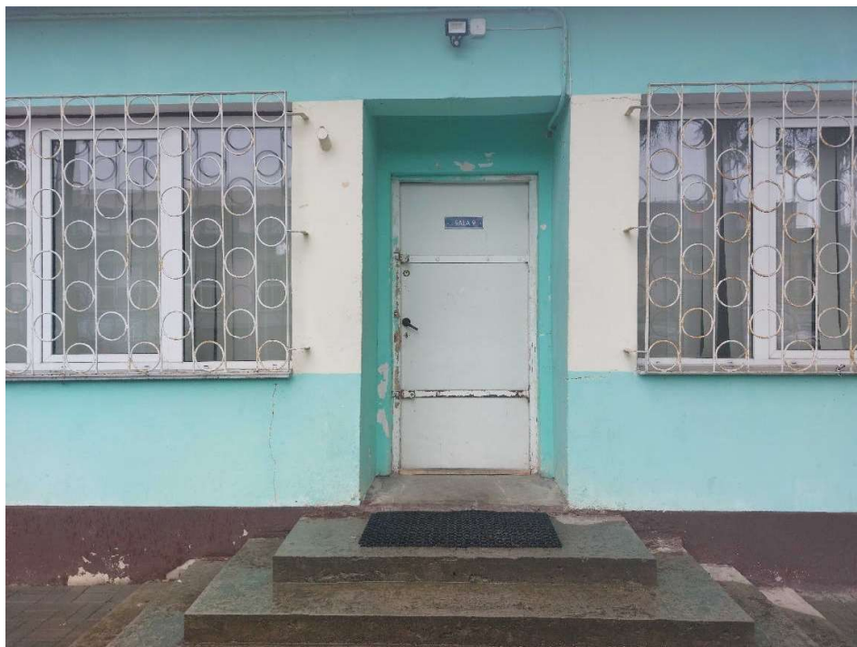
Fot. 8. Część zachodnia budynku – widok na wejście do sali nr 9.
