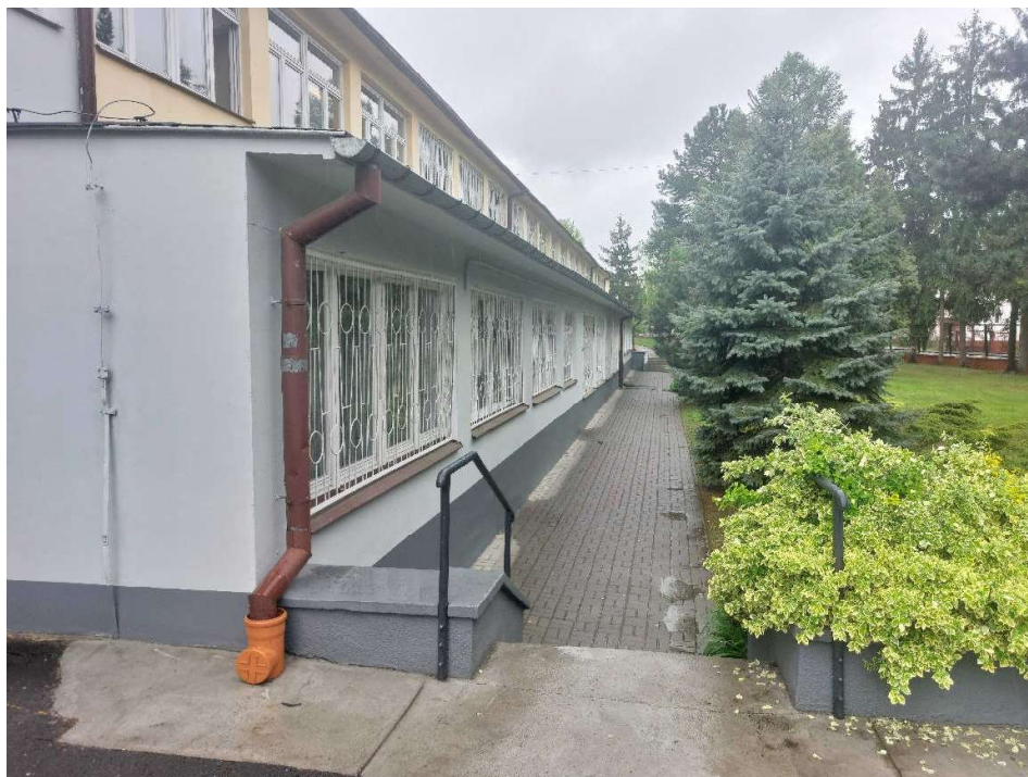
Fot. 23. Widok na część frontową budynku szkoły.
