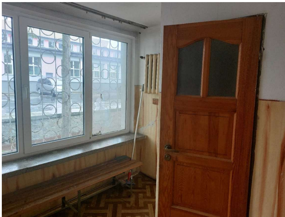
Fot. 13. Sala nr 10 w części zachodniej budynku – widok na pomieszczenie z łazienką.
