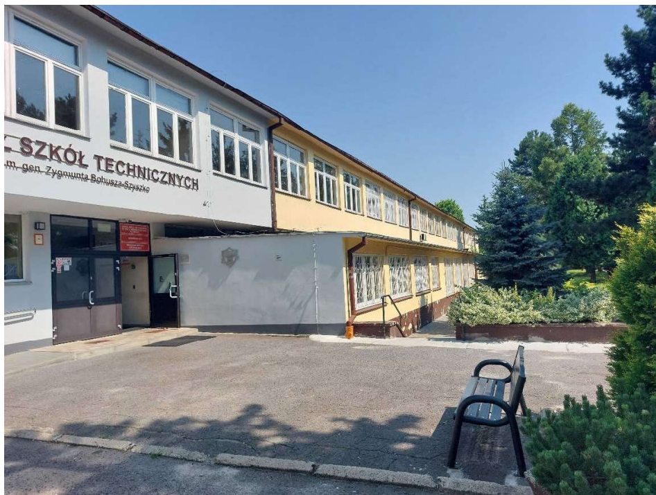
Fot. 27. Widok na część frontową budynku szkoły.
