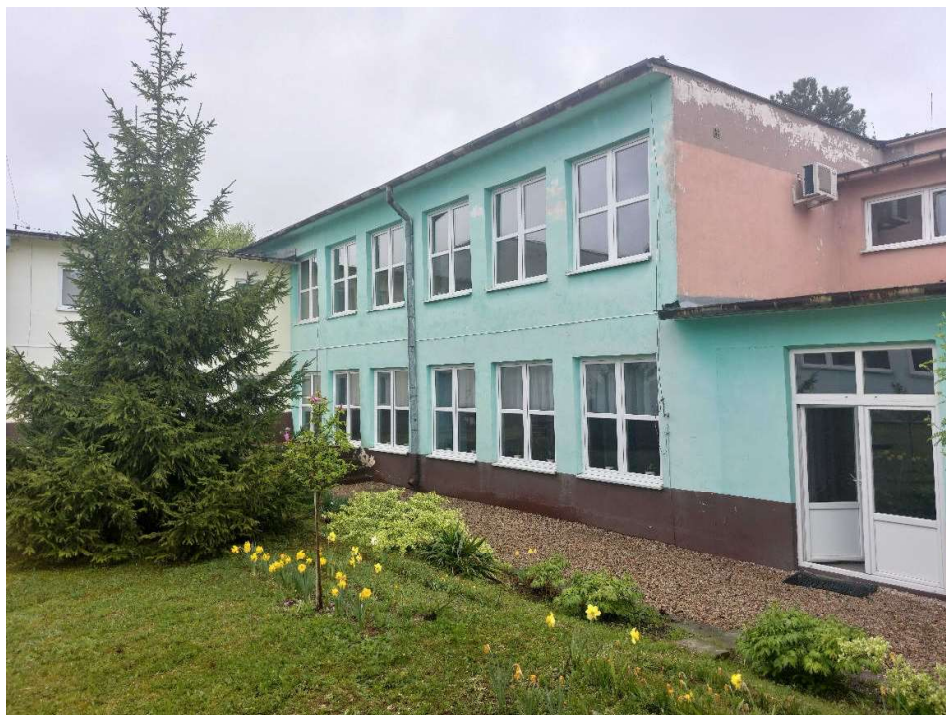
Fot. 21. Część wschodnia budynku – widok od strony patio na okna korytarza.
