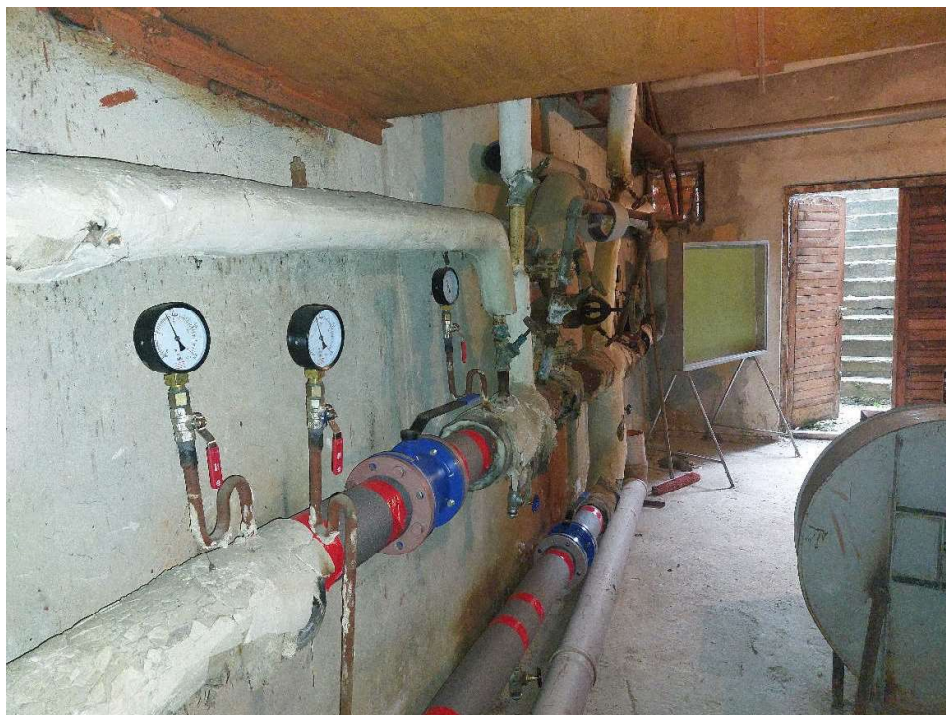
Fot. 57. Pomieszczenie węzła cieplnego.
