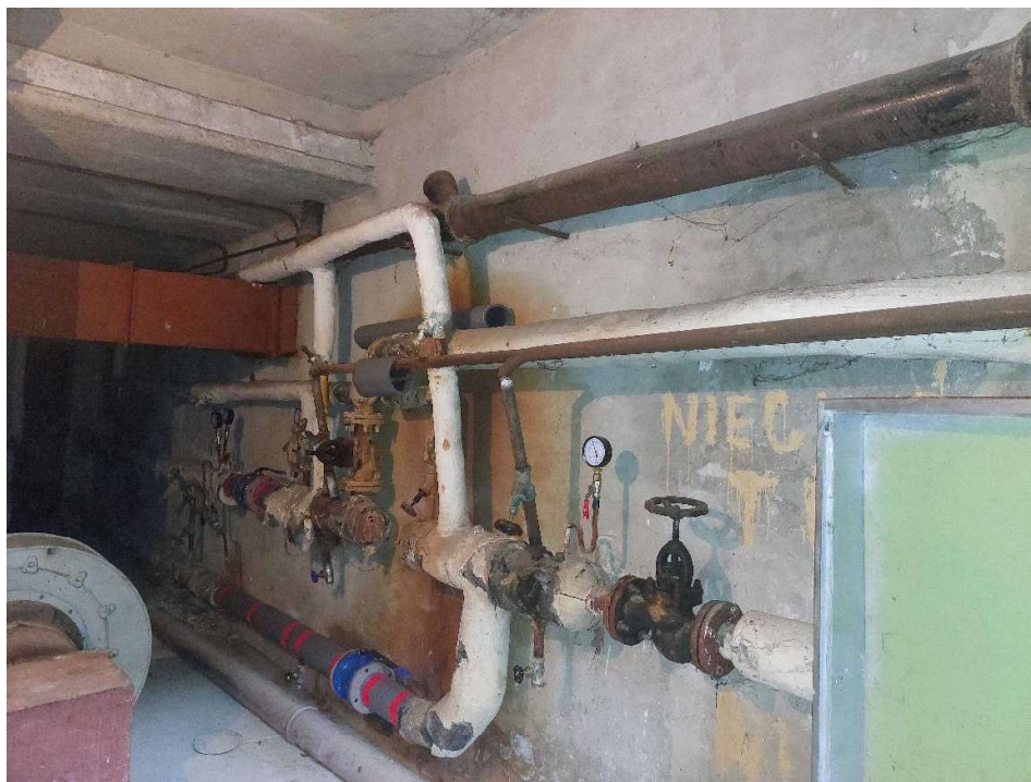
Fot. 56. Pomieszczenie węzła cieplnego.
