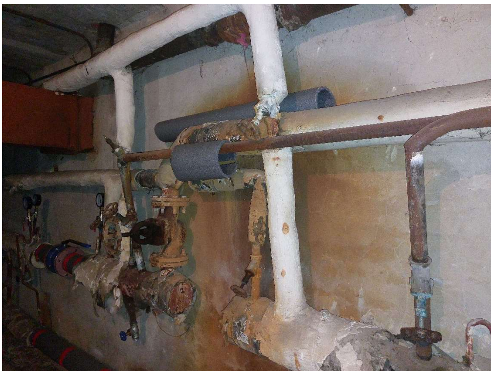
Fot. 58. Pomieszczenie węzła cieplnego.
