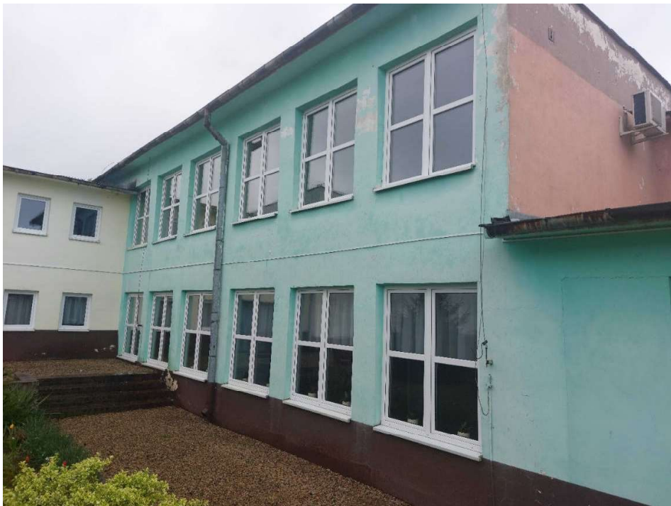
Fot. 20. Część wschodnia budynku – widok od strony patio na okna korytarza.
