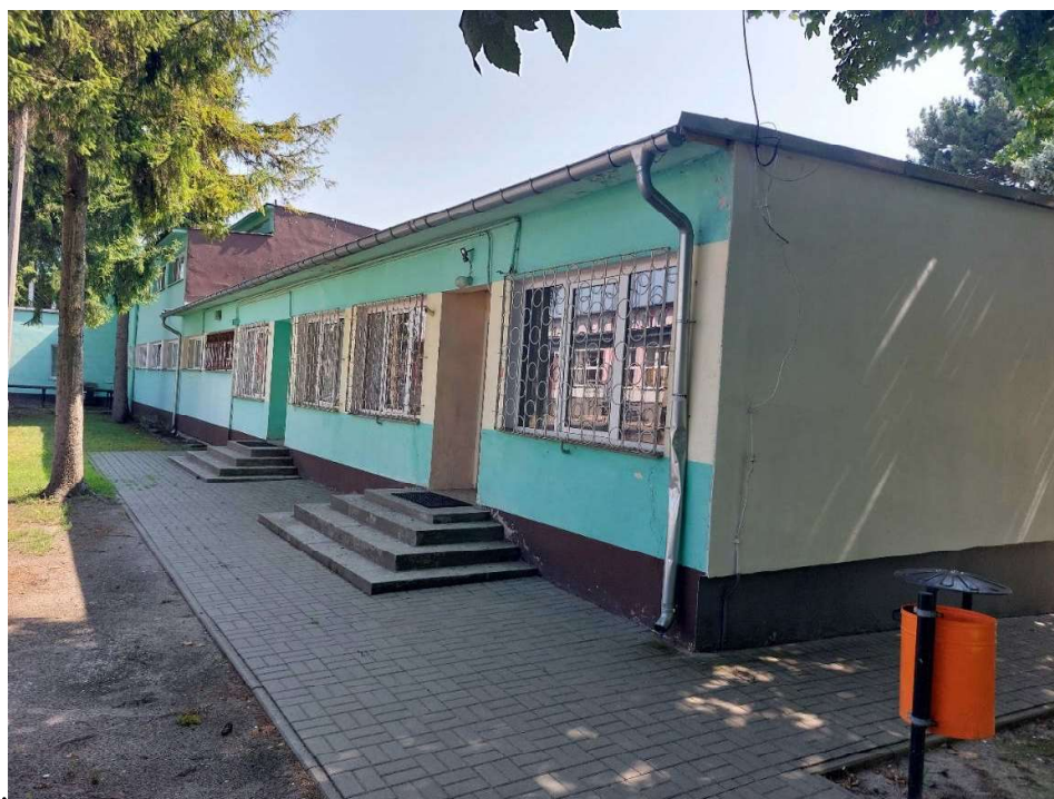
Fot. 16. Część zachodnia budynku – widok na salę nr 9 i 10.
