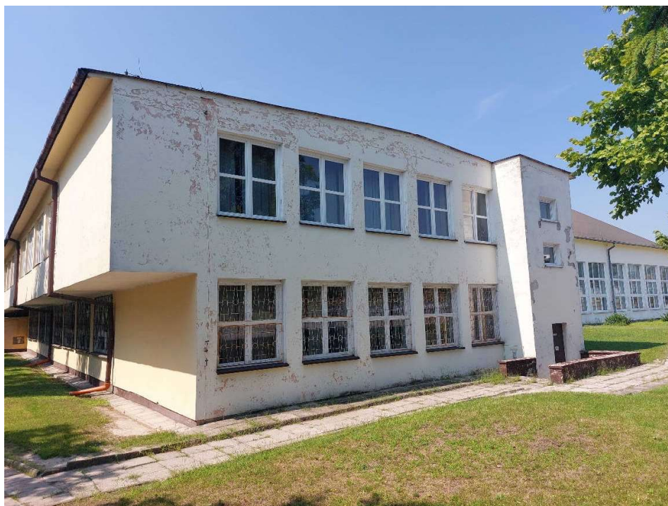
Fot. 2. Część wschodnia budynku – widok na salę 26.
